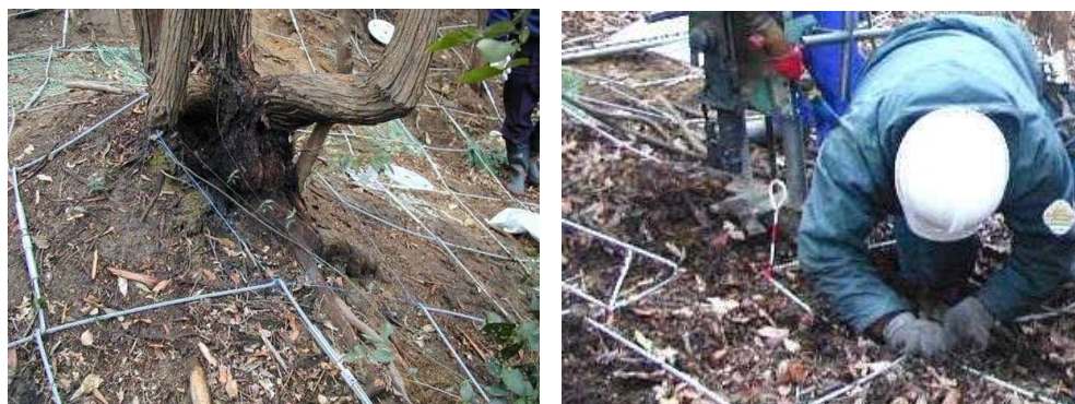
図 2-3-11 ユニットネット敷設状況②
