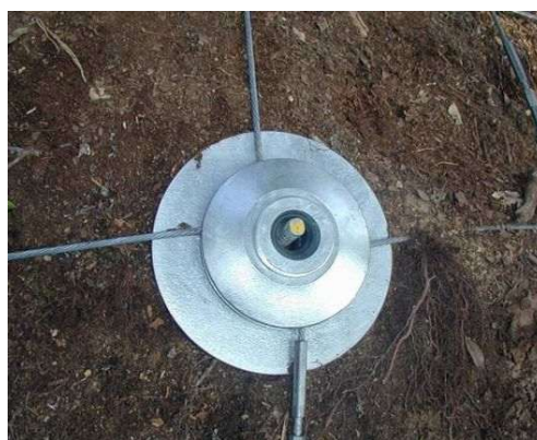
上部支圧板取り付け
