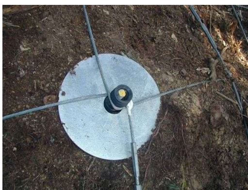
下部支圧板取り付け
