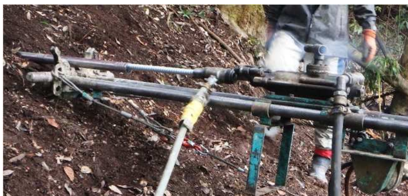
図 3-4-2 DKドレーンパイプ打設
