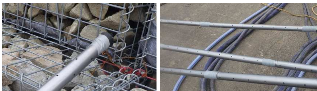
図 3-4-8 テーピング補強を施した例
