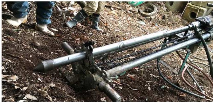
図 3-3-2 打設機械据付
