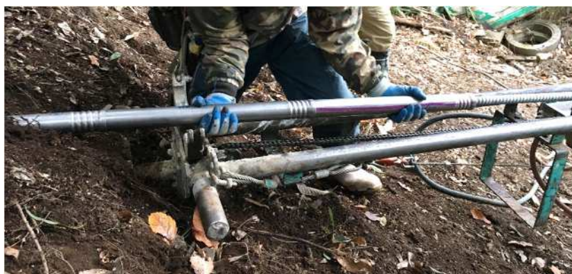
図 3-4-6 DKドレーンパイプの継ぎ足し
