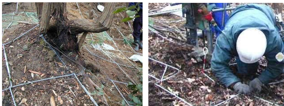
図 2-3-11 ユニットネット敷設状況②
