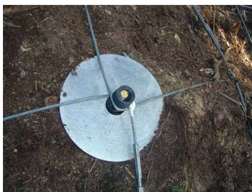
下部支圧板取り付け
