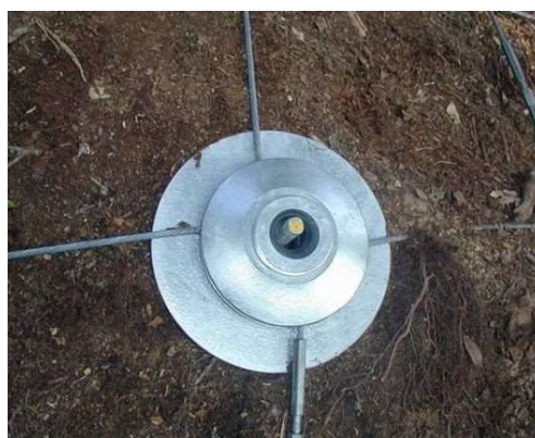
上部支圧板取り付け
