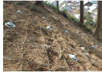
急傾斜地崩壊対策工事
