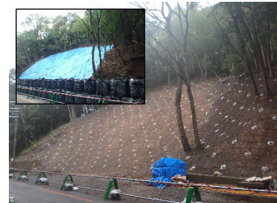
道路災害復旧工事 施工直後
