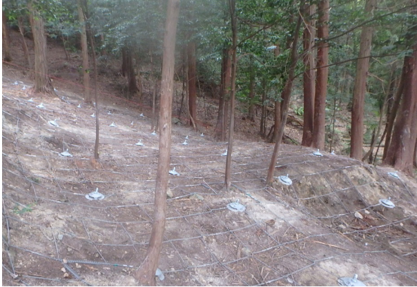
ユニットネット工法 施工状況
