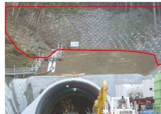
トンネル坑口の法面对策工事
