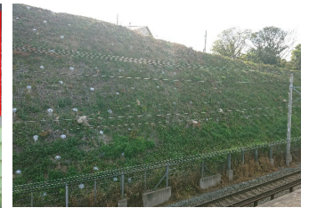
鉄道法面对策工事
