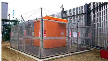
火薬類取扱所
