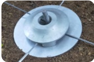
UN支圧板設置
