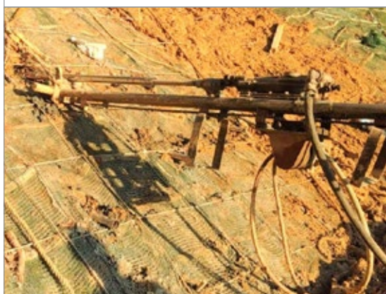
DK ドレーンパイプの打ち込み
