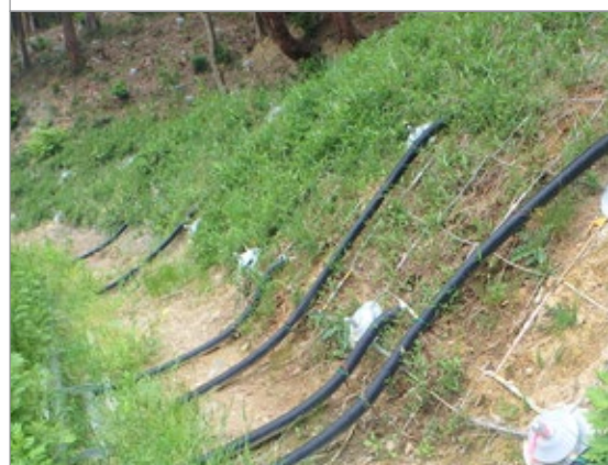
ポリエチレン管による流末処理
