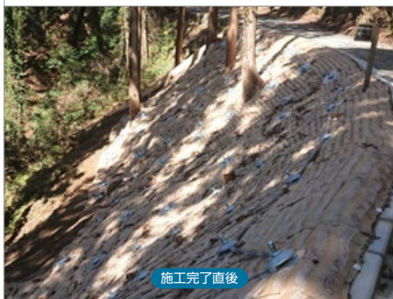
崩壊の起きた演習林道の復旧
